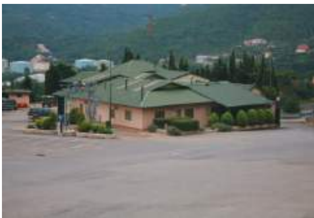
Vista della palazzina uffici e della pesa
