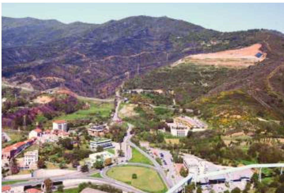
Vista aerea della strada di accesso alla discarica di Bossarino
