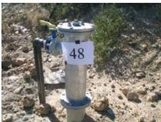
Pozzo di captazione
