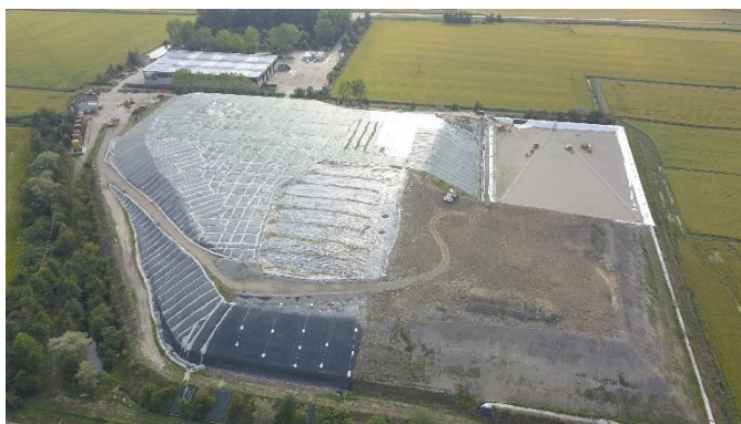
Figura 4 Vista aerea della Discarica
